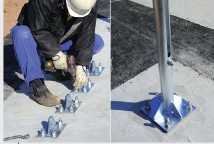
2 端末支柱、端末金具をアンカーボルトに固定します。
