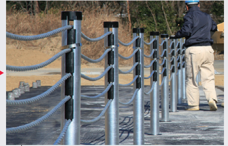
6 ワイヤロープ、間隔材、ストラップをセットし、キャップを取り付けます。
