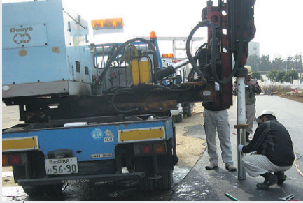
1 アスファルトをコア抜きし、エアースライカーによりスリーブを打込みます。
