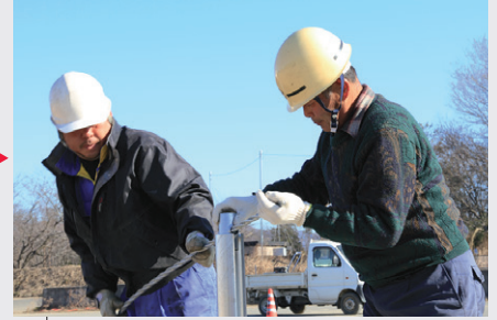
3 端末支柱用間隔材にワイヤロープを通し、端末支柱の溝にストラップと共にセットします。
