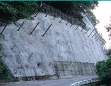
ロックネット工法
