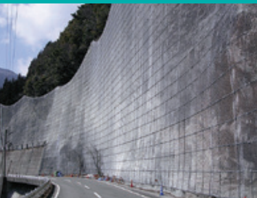
カーテンネット工法
