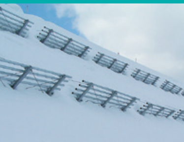
吊柵(雪崩予防工)
