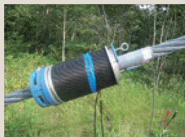
小規模吊橋主索の測定例
