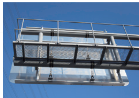
標識パネル落下防止ワイヤロープ
