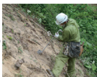
3 グラウト材注入
