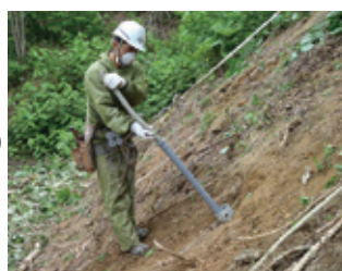
3 グラウト材挿入
