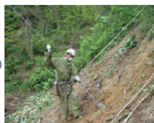
4 アンカー下部材挿入
