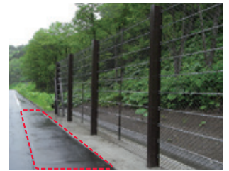
舗装打ち替え
