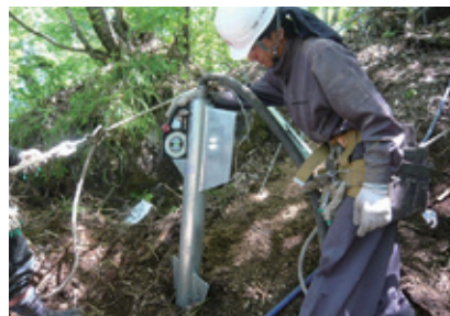
土砂部用アンカー設置
