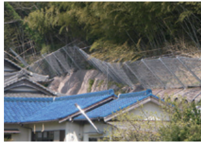
民家裏山設置
