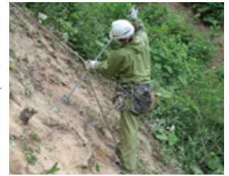
4 アンカーシステム挿入
