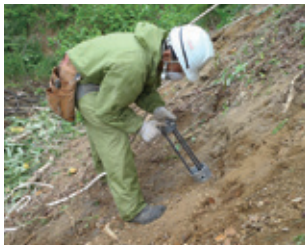
1 穿孔用スペーサー挿入
