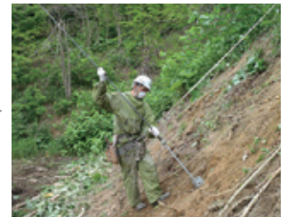
4 アンカーシステム挿入
