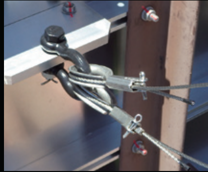
標識柱落下防止ワイヤロープ
