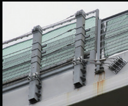
落下物防止柵落下防止ワイヤロープ
