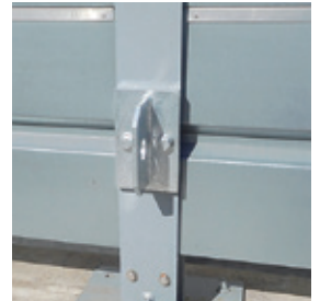
支柱落下防止ワイヤロープ 後付金具
