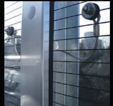
アクリル透光パネル落下防止ワイヤロープ
