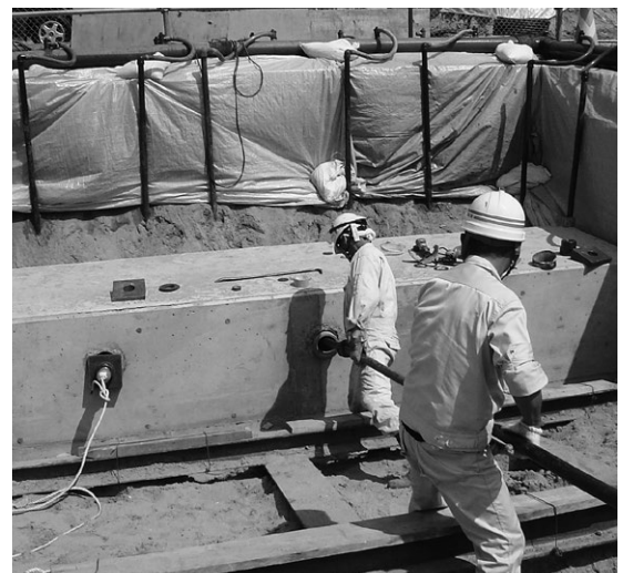
人手による架設
