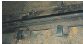
レール締結装置設置状況
