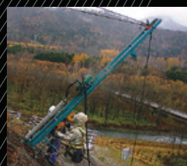
法面直角方向設置
