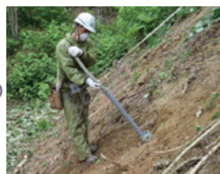
③ グラウト材挿入
