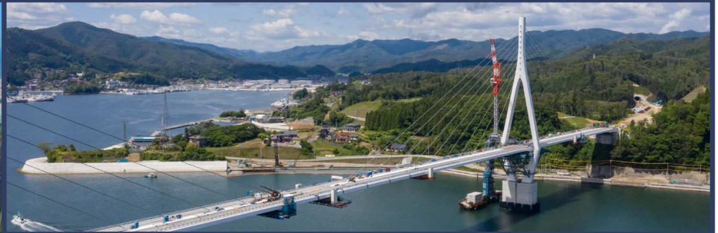
橋梁ケーブル
