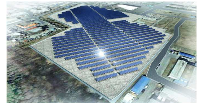
写真) 東京製綱八戸太陽光発電所
