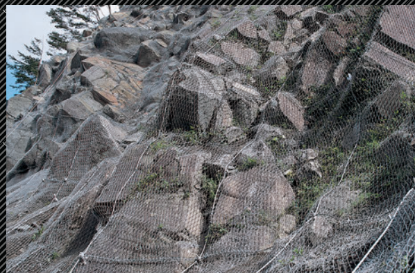
The thick net fixes the unstable stones of the slope Массивная сетка фиксирует неустойчивые камни на горном откосе
