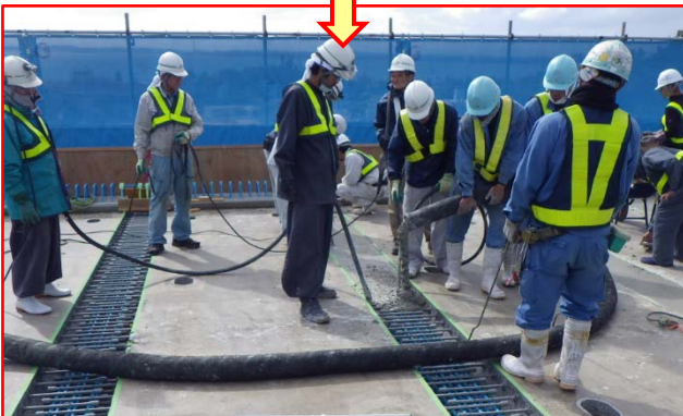
間詰部コンクリート打設
