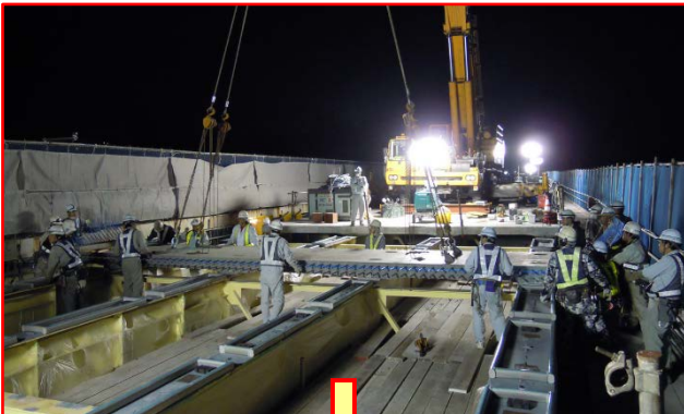
PCa 床版架設
