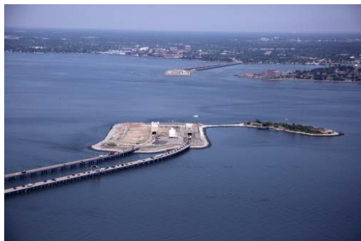
現在のハンプトンロードブリッジトンネル
