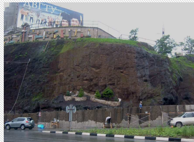
落石対策工事現場:ウラジオストック (密着型安定ネット)
