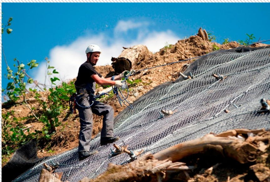
【施工例】ソチオリンピック会場連絡道路 (マイティーネット工)
