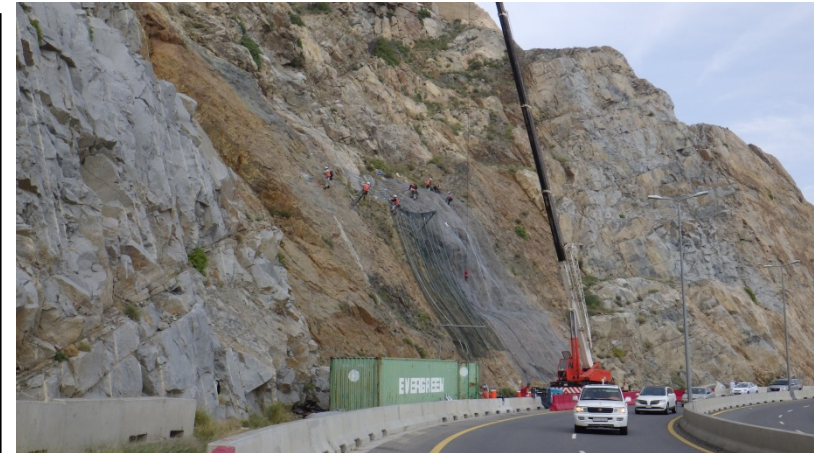
サウジアラビア・メッカ近郊のデモ施工
