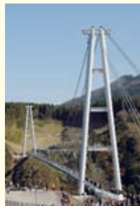
平成18年10月に長さ390m、高さ173mの日本一の人道橋吊橋が完成しました。橋の上からは、「日本の滝百選」に選ばれた震動の滝をはじめ、九酔溪、鳴子川渓谷の雄大な景色が満喫できます。幅員は1.5mで、大人1,800人の加重に耐えるように設計されています。当社は、この吊橋に関するメインケーブル、ハンガーロープ、耐風支索などの全てのケーブルおよびワイヤロープを供給しております。本吊橋の特徴の一つとして、フェアリング（風よけ）という技術を用い、中央部の床版が、すのこ状のグレーチングになっているため下を見ることができ、スリリングな眺望を満喫できます。本吊橋の開通が紅葉の時期にあたったこともあり、入場者は開通9日後に10万人を超え、開通24日後に年間目標の30万人を達成、今年4月10日には100万人を突破する等、多くの観光客が訪れております。
