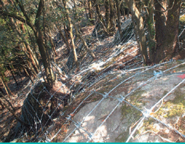
ロープネット工法
