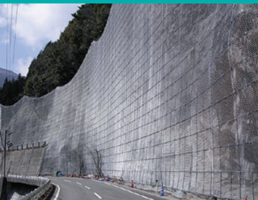
カーテンネット工法
