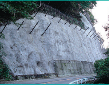
ロックネット工法
