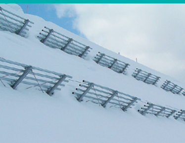
吊柵(雪崩予防工)
