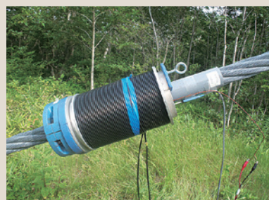
小規模吊橋主索の測定例
