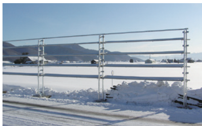
無風時(逆風時)の防雪板の状況
