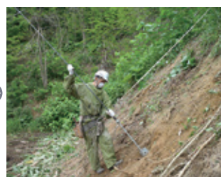
4 アンカー下部材挿入
