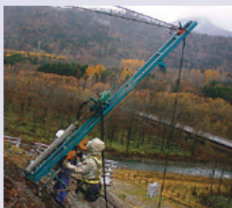
法面直角方向設置
