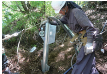
土砂部用アンカー設置
