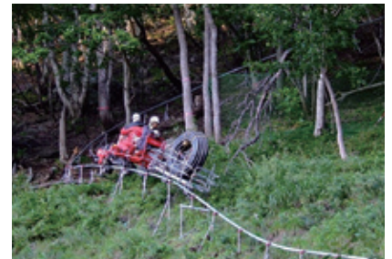
モノレールを利用した荷揚げ
