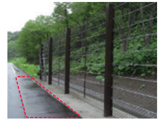
舗装打ち替え
