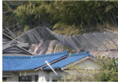
民家裏山設置
