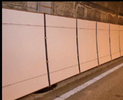
内装パネル落下防止ワイヤロープ
