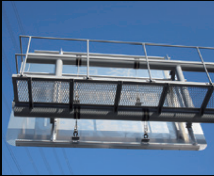
標識柱落下防止ワイヤロープ
