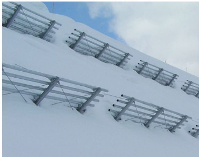
吊柵式雪崩防止施設
