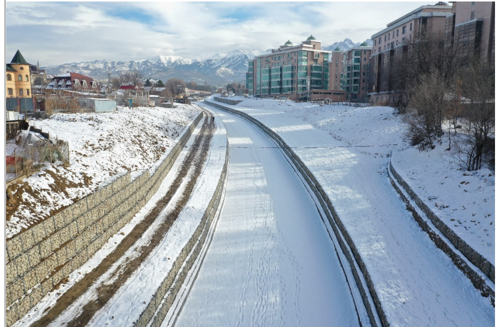
Rockboxを敷設したエセンタイ川
