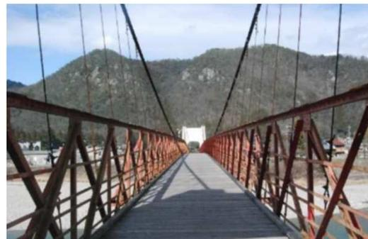
写真) 美濃橋 ケーブル補強工事後
