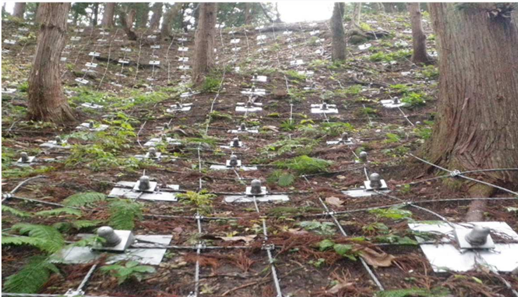
国内:GF式鉄筋挿入工法
