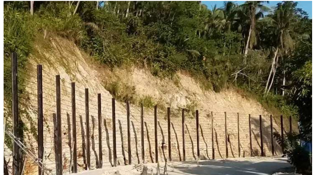
フィリピン:落石防護工
