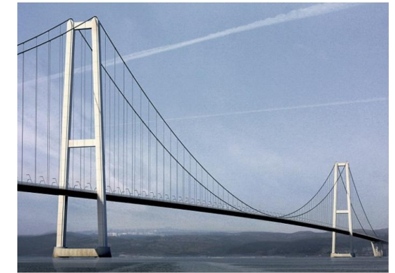
オスマン・ガジ橋(トルコ) 横長2,907m、最大支間長1,550m
