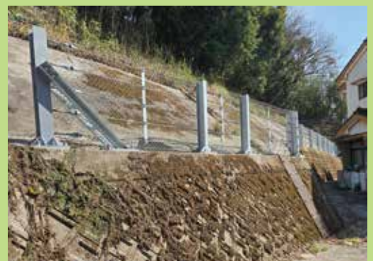
既設擁壁への設置
