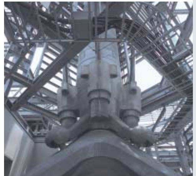
ピボット支承部
