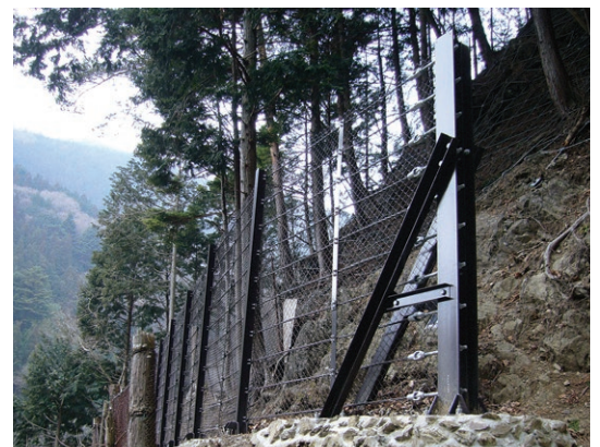
タフコーティッド塗装施工例 東京都奥多摩町
