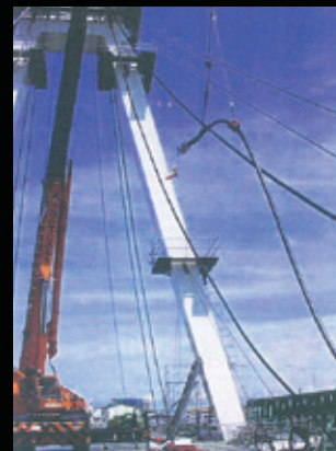
塔側定着部へのソケット吊り上げ
