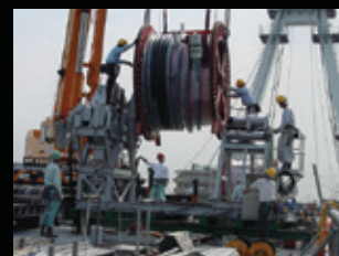
ケーブルのアンリリーラーへの設置
