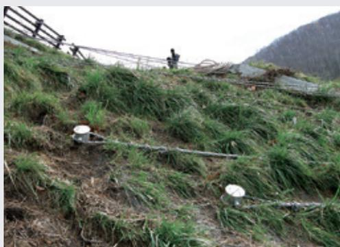
吊柵使用例(斜面異方向部設置拡大)
