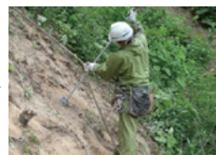
④ アンカーシステム挿入
