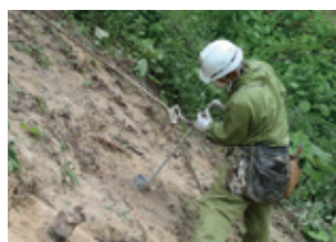
③ 定着材注入
