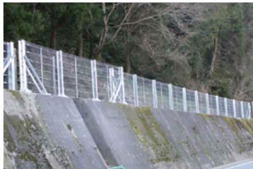
既設擁壁への施工
