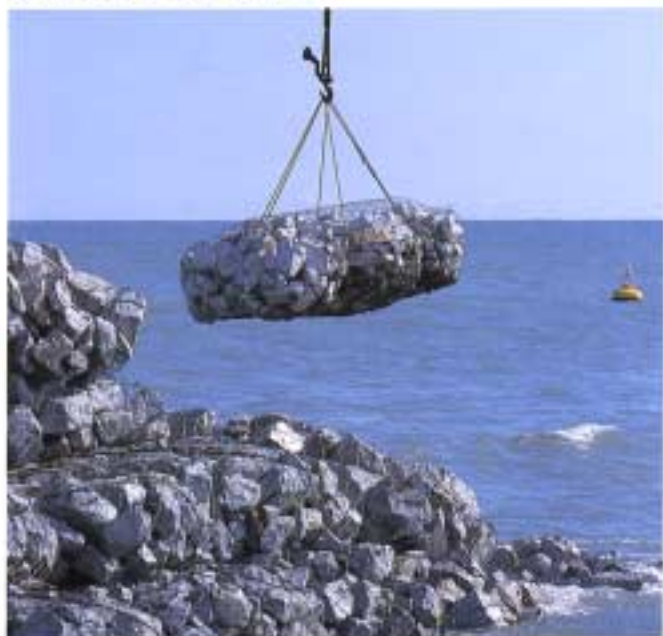
⑤ロックマットを設置
