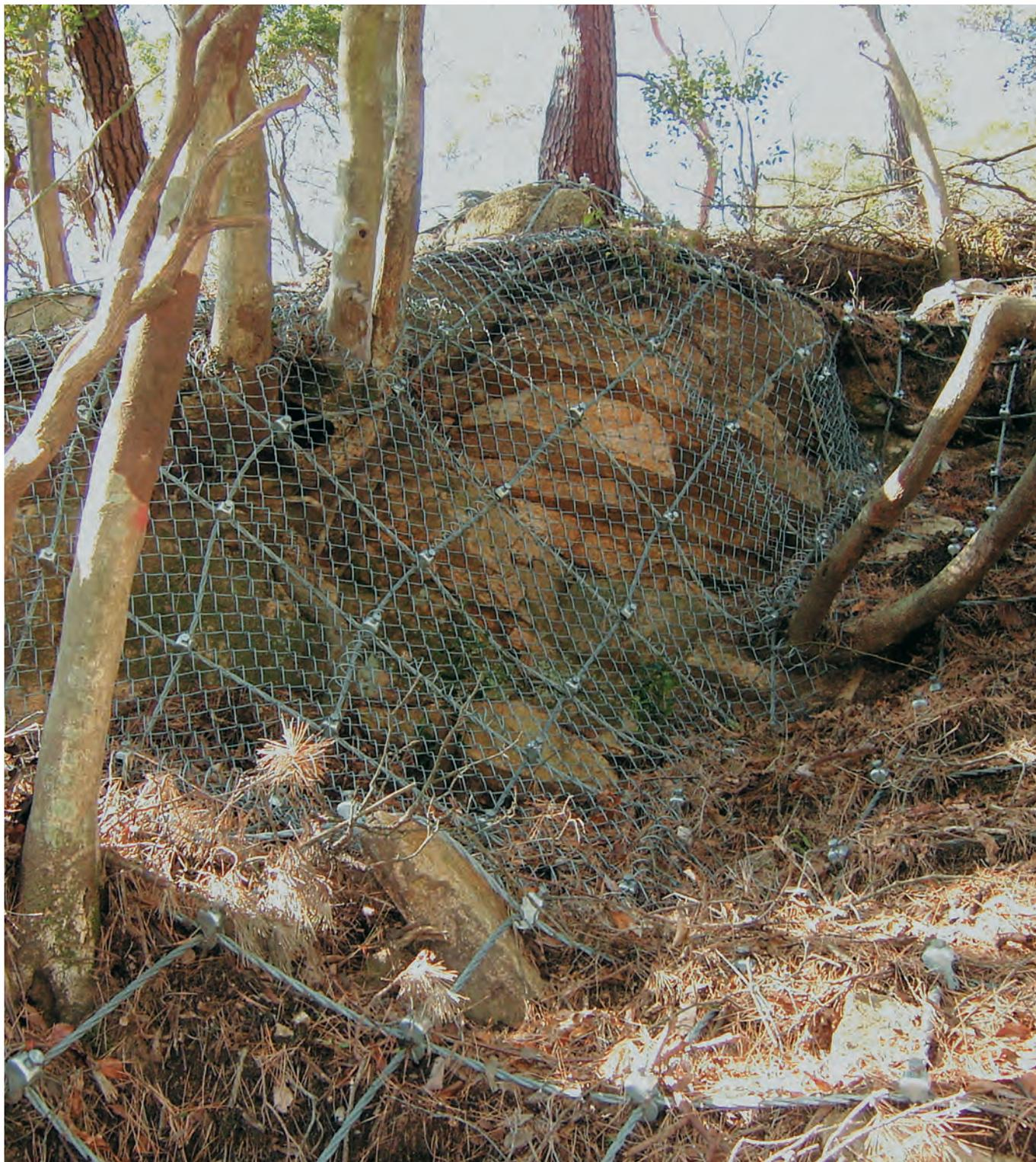
ロープネットは大きな浮石を安定させます。小さな浮石が混在している場合や大きな石が碎けて小さな浮石・転石の発生が予期される場合は、その部分のロープネットに金網を取付けます。
