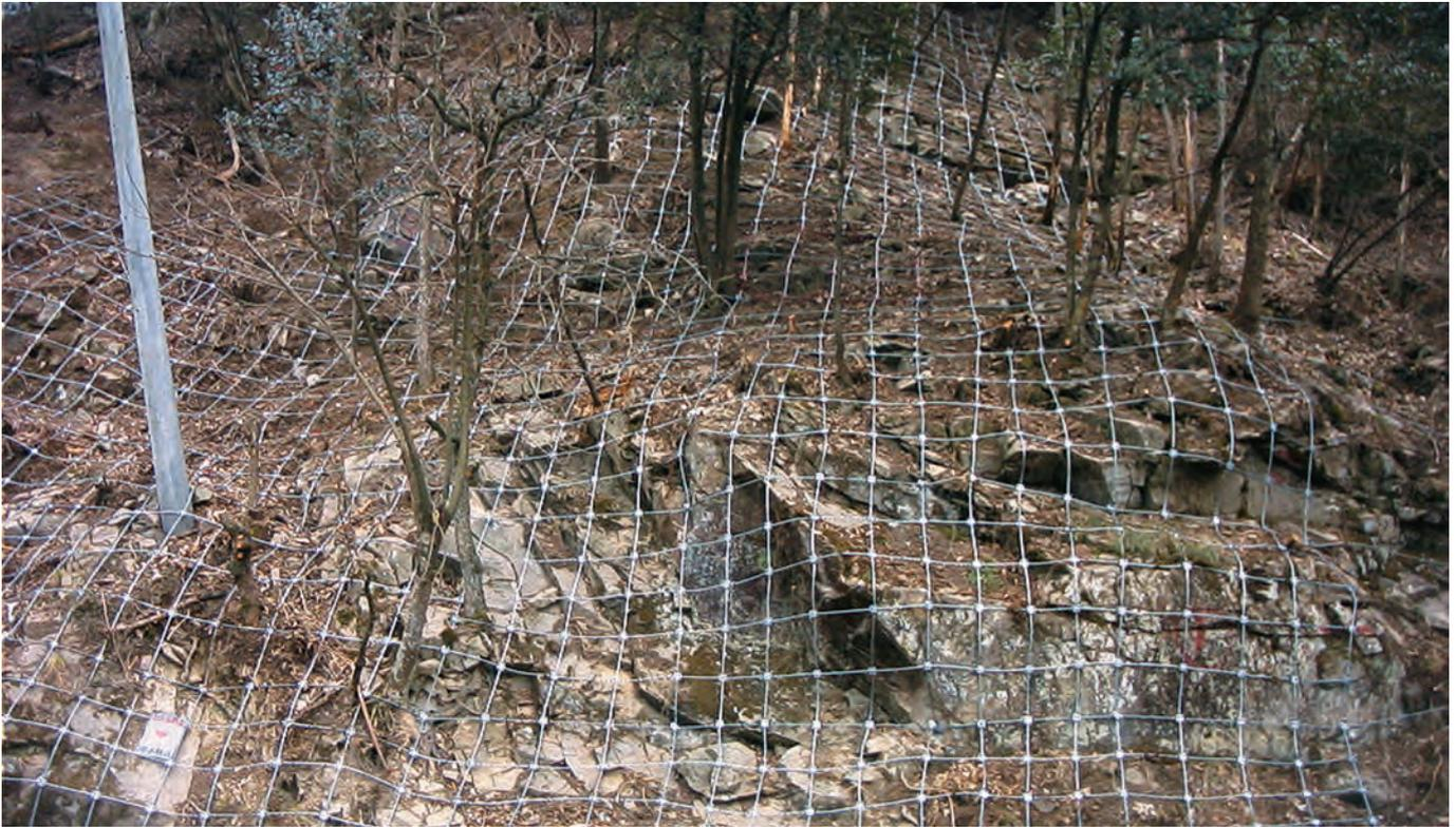
樹木の位置にあわせてロープの方向や間隔を調整しながら施工しますので、伐採は最小限にとどめることができます。
