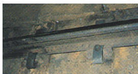
レール締結装置設置状況
