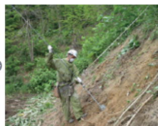
④ アンカー下部材挿入
