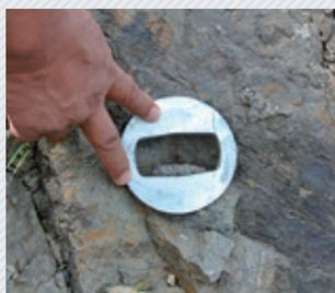
リッププレートは予めTSKイーアンカー本体に通しておき、長手方向を必ず設置方向に合わせてTSKイーアンカー本体を隙間無く挿入する。セメントがTSKイーアンカーの首元周辺までオーバーフローしたことを確認してからならします。
