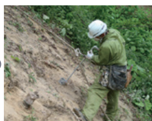
③ グラウト材注入
